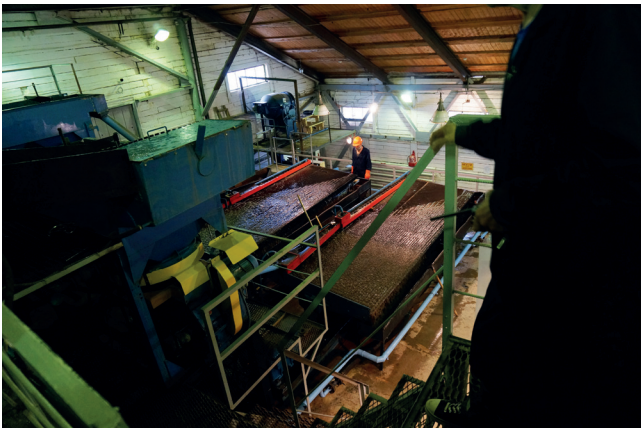
Шлихообогащительная фабрика — конечное звено в процессе обогащения россыпной платины
